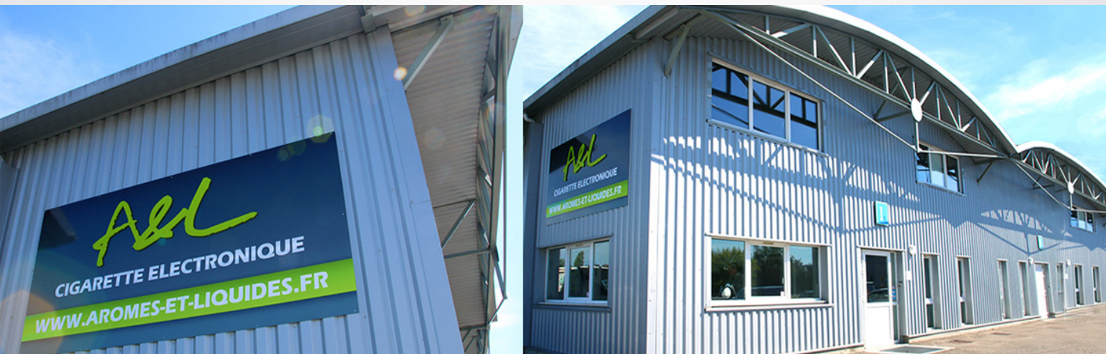
1er entrepôt A&L de 350m 2 (début 2014)
